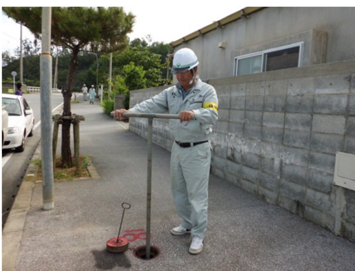
ドレン作業①
