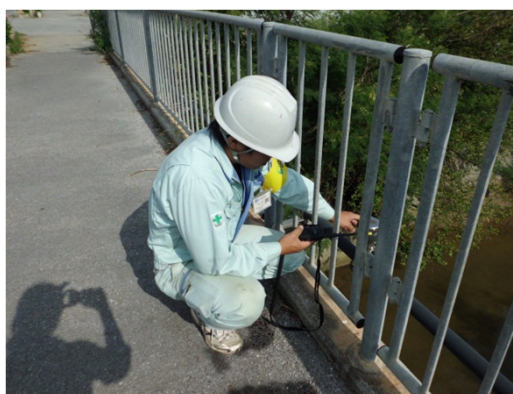
空気弁からの水抜き作業
