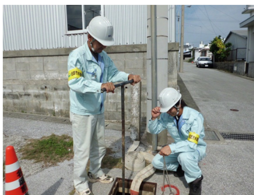
消火栓でのドレン作業
