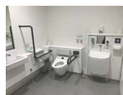
オストメイト付トイレ (兵庫県洲本市)
