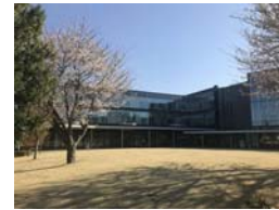
庁舎前の防災広場 (埼玉県北本市)
