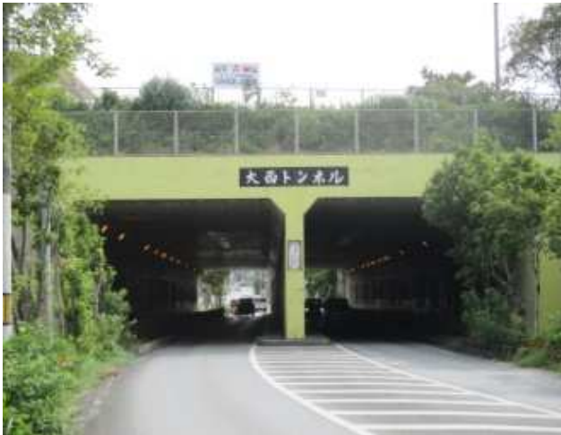
大西 トンネル(上下線：2基)
