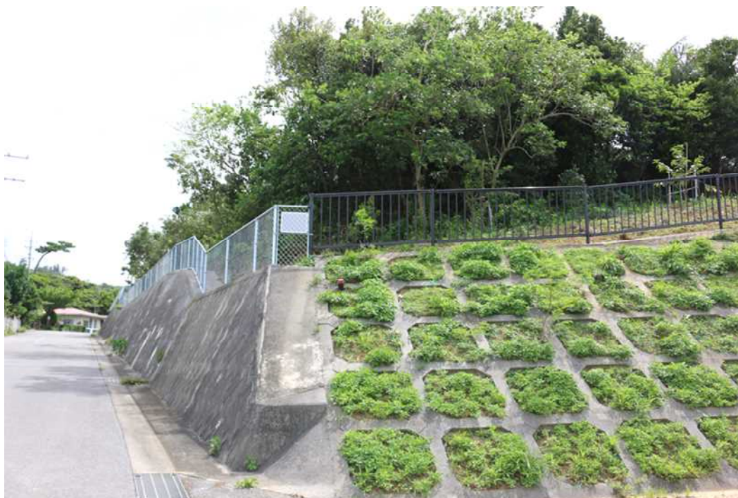
転落防止用のフェンスが設置された天洋森
