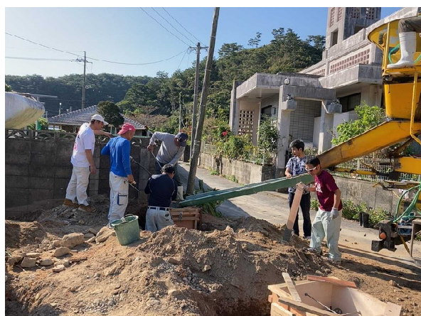
東屋建設中の様子
