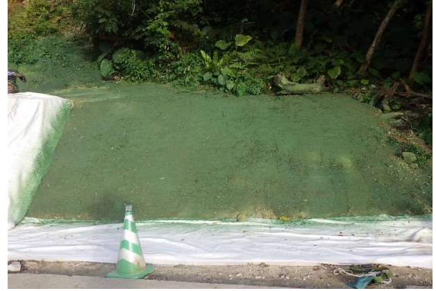
団粒化剤吹付状況
