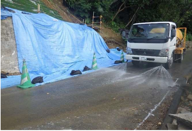
散水車による道路への散水及びブルーシート設置状況
