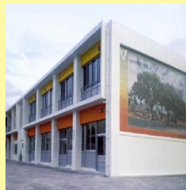
屋部小学校校舎改築事業
