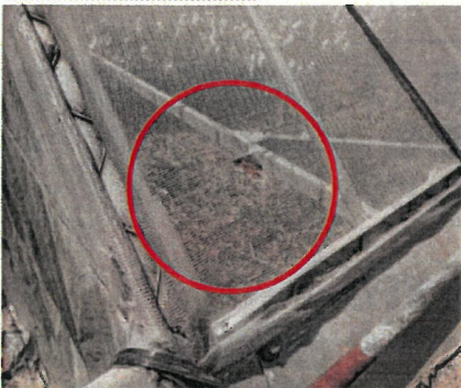
ネット等の破れの補修
