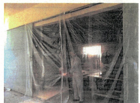
集荷場入口のネット設置
