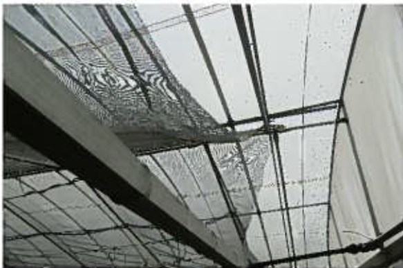
ハウス内部に遮熱ネットを被覆し、日焼け対策を施した事例(石垣市)
