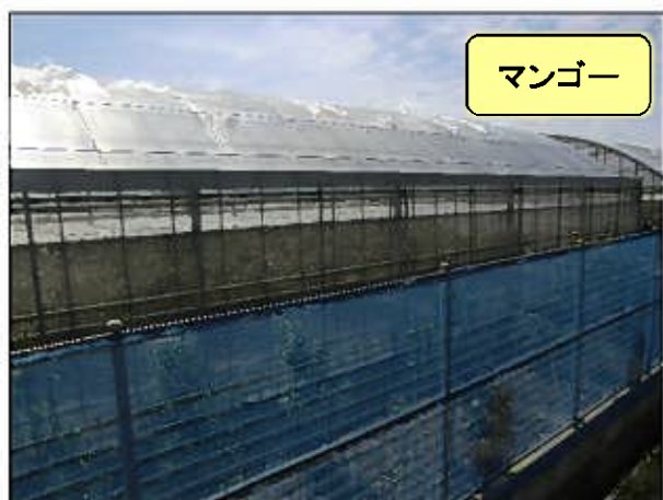
防風垣(ネット)を設置しての対策(宮古島市)
