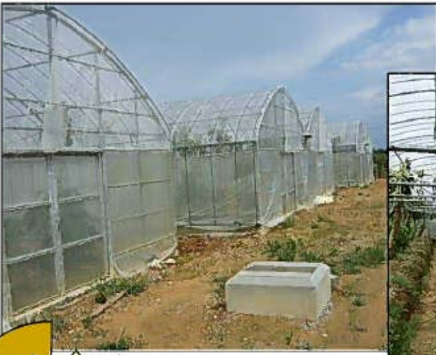
防風垣のないネット式鋼管施設(ネットで被覆)
