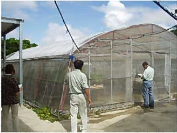
トラス構造を用いたハウス(那覇市)
