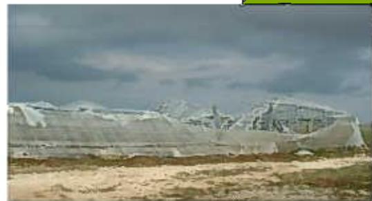
●台風により倒壊したハウス② （H15年9月台風第14号 最大瞬間風速74.1 m/s）
