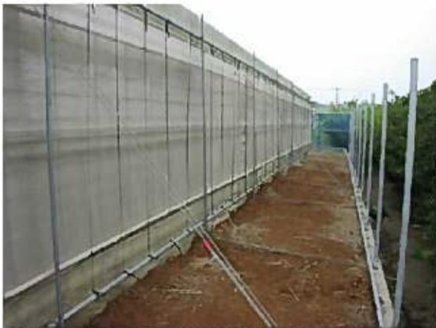
ワイヤーによる引張補強(宮古島市)
