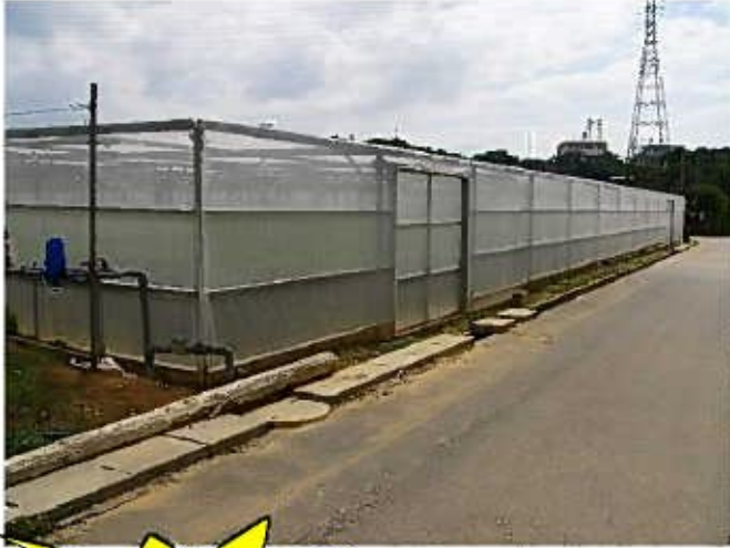
平張施設の外観 屋根面1~3mm、側面0.6mmの防虫ネット で被覆されている。
