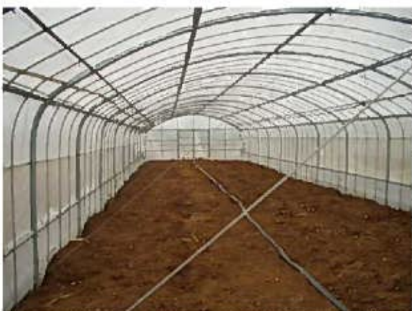
ハウス内にワイヤーを引張することもハウスの補強に役立つ(南城市)
