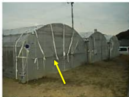
ハウスの出入口や天窓、谷間部分は補強材でしっかりと固定する。
