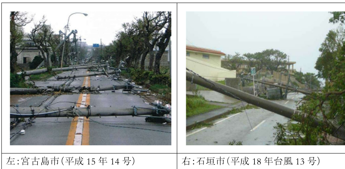
写真 2 台風による電柱倒壊状況
