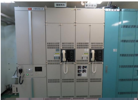
多重無線設備更新(安波ダム)
