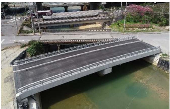
福地川 上流側より
