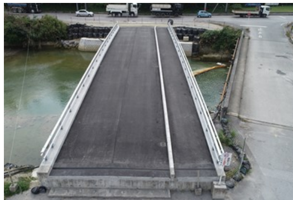
A2側（集落側）より
