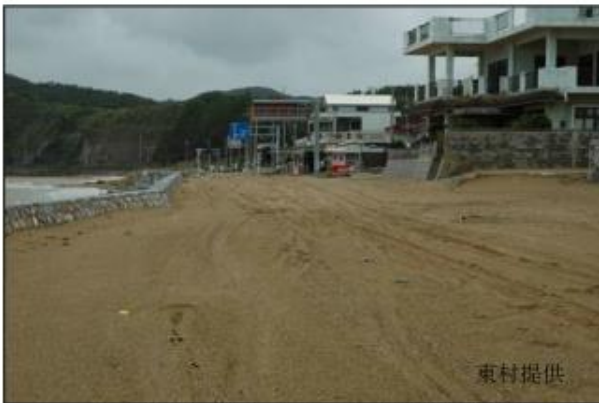
打ち上げられた砂(東村平良 県道70号線)
