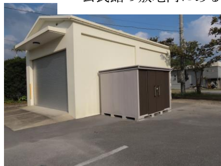
名護市が設置した防災倉庫 公民館の敷地内にある。
