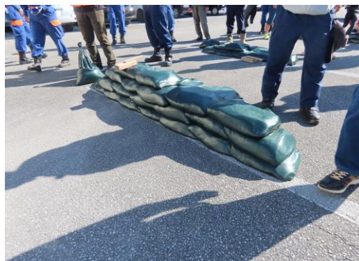
土のう設置状況
