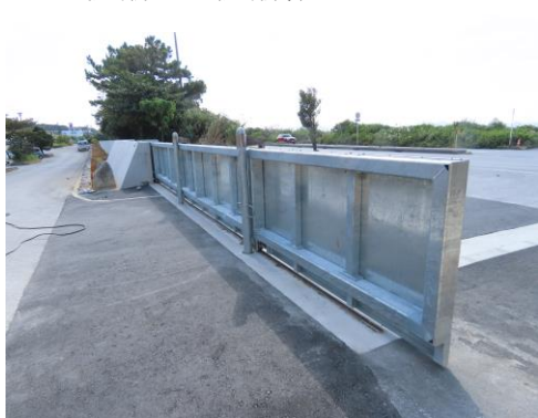
防潮壁と防潮扉
