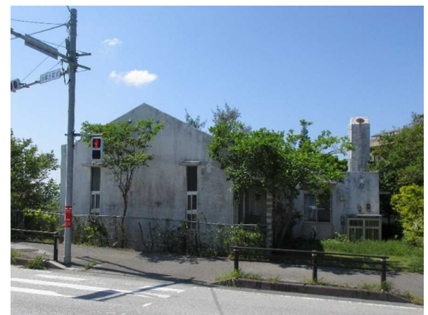
旧屋部教会(屋部小学校前) 令和2年12月より令和3年2月まで改修工事
