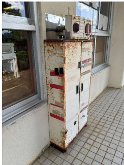
■今回工事で撤去更新
