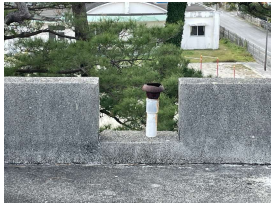
■今回工事で通気金具更新
