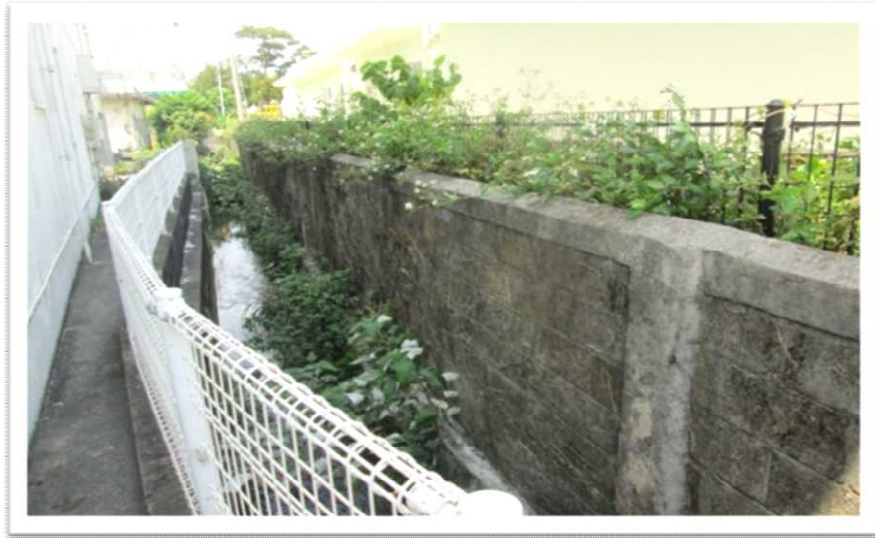
【写真-9】 左側敷地外(水路)/右側敷地内(園庭) (東江幼稚園)
