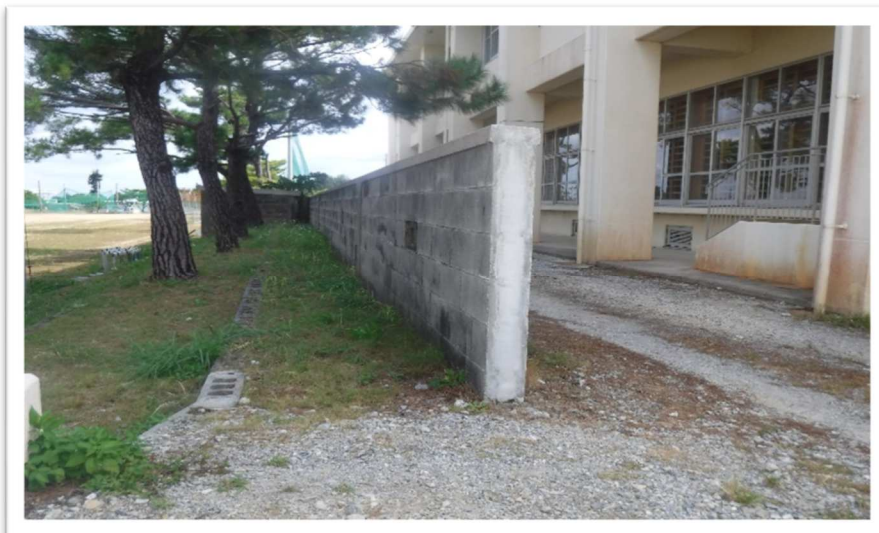
【写真-10】 左側中学校(運動場)/右側小学校敷地内(体育館) (久辺小学校)
