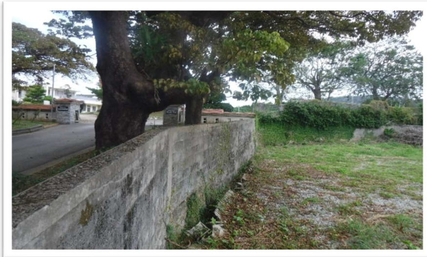
【写真-7】 左側敷地内(正門通り)/右側敷地外(民地) (真喜屋小学校)
