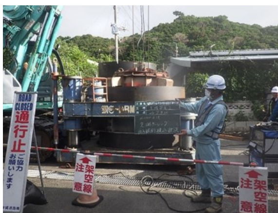
推進工 先導体設置
