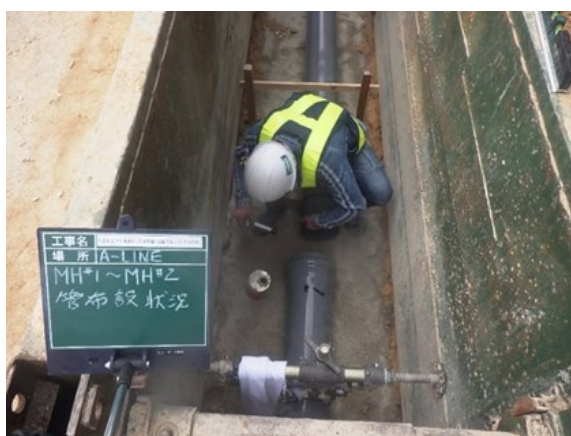
開削工 管布設状況
