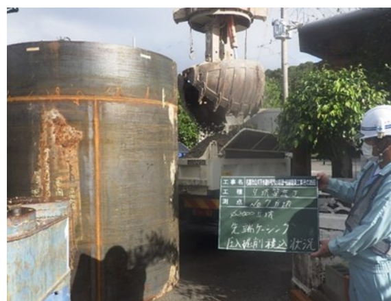
推進工 中込材完了状況
