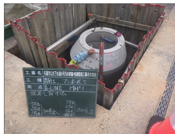
開削工 マンホール設置工
