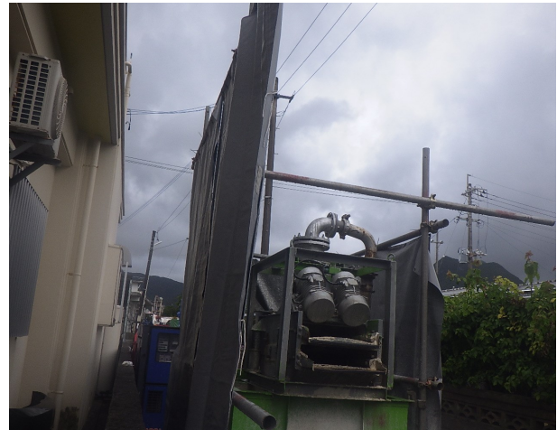
騒音防止の為遮音ネットを設置
