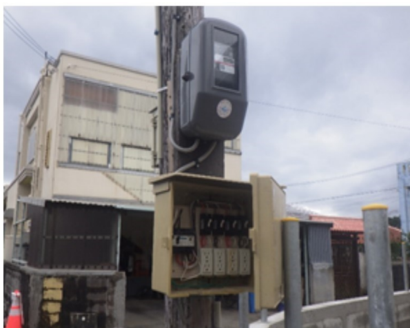
騒音防止の為電気の引込工事実施
