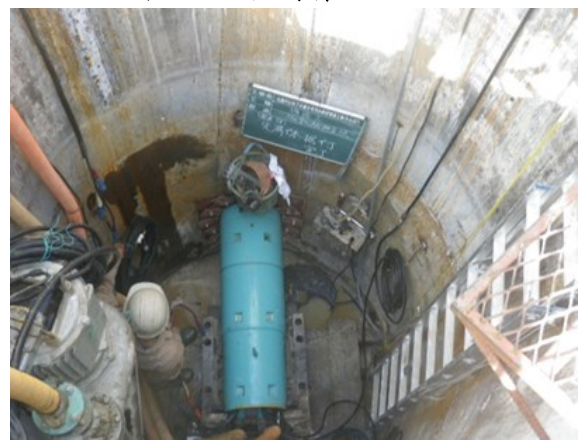
推進工 塩ビ管設置状況
