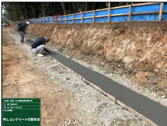
【均しコンクリート打設状況】
