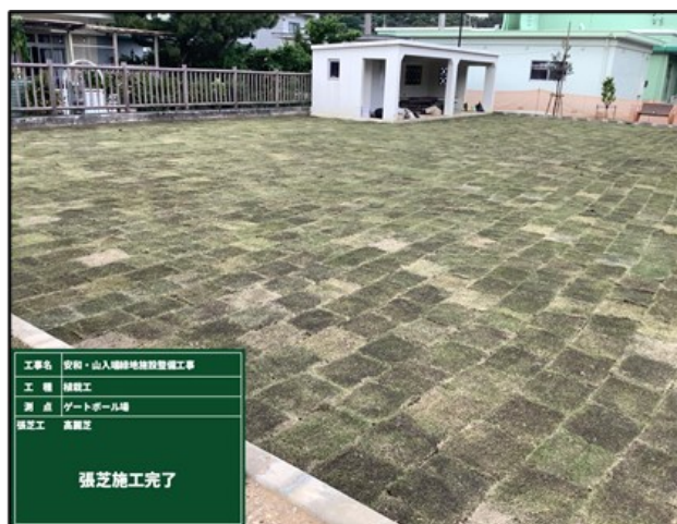
【張芝施工完了】
