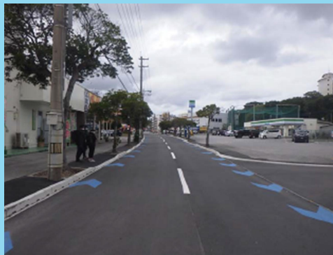
市内に整備された自転車指導レーン
