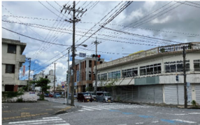
無電柱化がされていない
