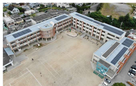
名護小学校の太陽光発電設備
