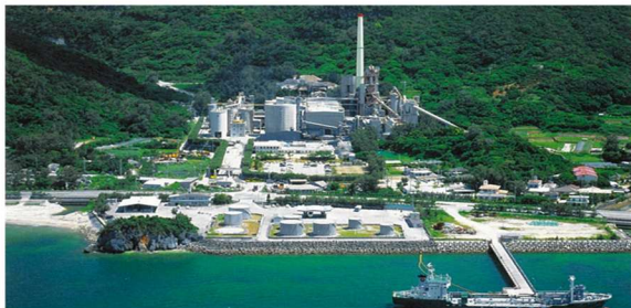
琉球セメント（株）屋部工場
