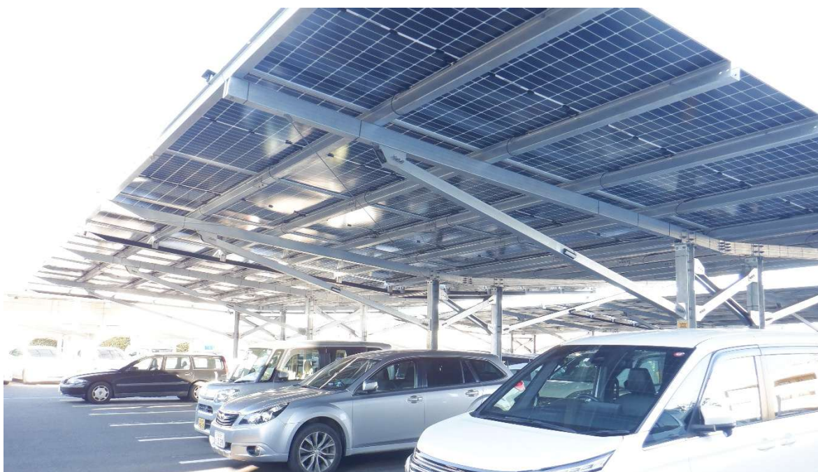
図9 ソーラーカーポートの例（茨城県八千代町役場駐車場）
