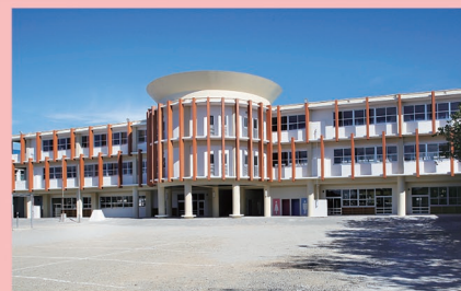
名護小学校校舎改築事業 (平成26年度～平成27年度)
