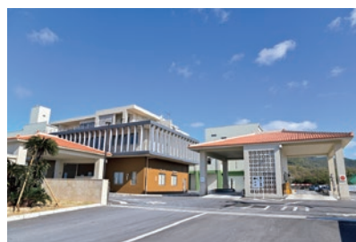
新ごみ処理施設の整備
