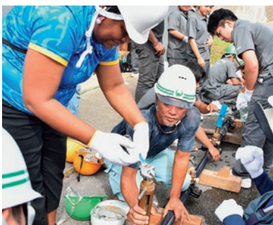
穿孔機を使い慎重に穴を開けていく
