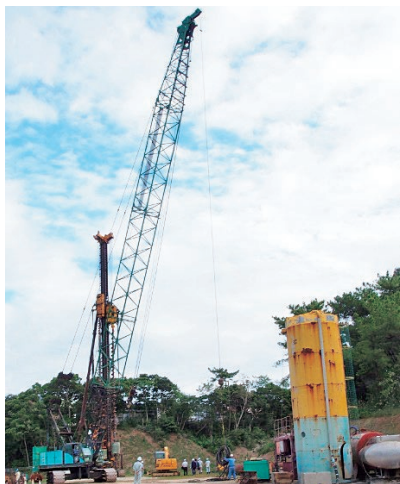
本館の基礎工事(11月)
