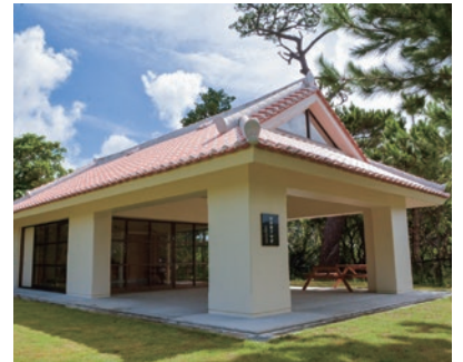
新しく建設された田井等区の神アサギ
