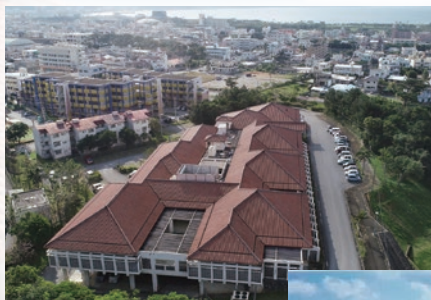
図書館建設後
