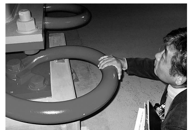
床下に設置された免震装置(巨大なパネ)の一部
