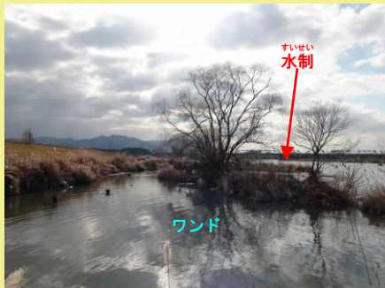
水制をつかった水際空間 (遠賀川・福岡県中間市) 水制によって護岸を守ると同時に、生きものの生活空間となる流れのゆるやかなワンドを創りだしている。
