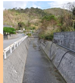
三面張り水路
