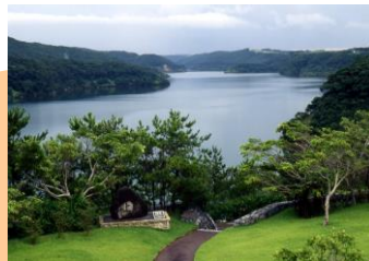
ダム(写真は福地ダム)
