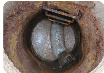
※マンホール内壁老朽化状況
